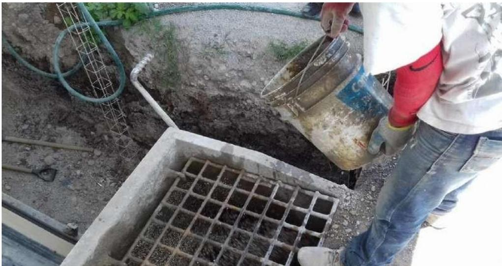
**Fig.8. Dosificación de cemento y agua.**
