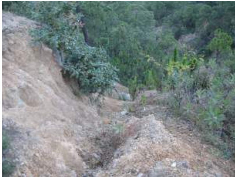
Fotografía No. 1. Erosión muy alta, La Concepción, Copanatoyac, Gro.
