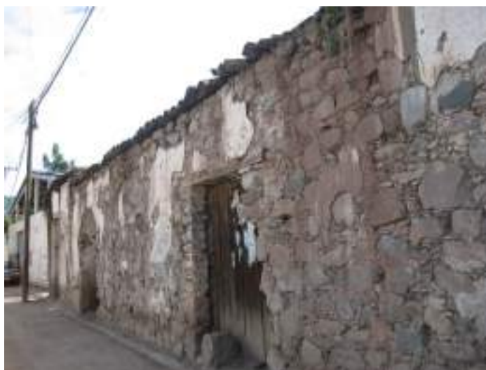
Fotografía No. 14.- Imagen de una vivienda deteriorada en el municipio de Copanatoyac
