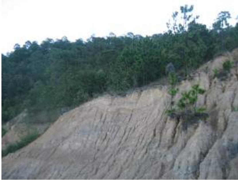
Fotografía No. 5. Formación de cárcavas, carretera Tlapa - Marquelia
