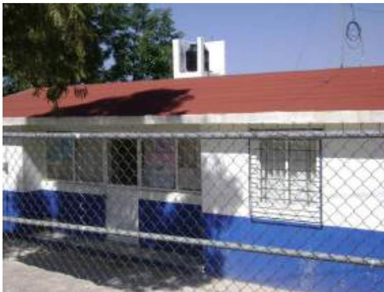
Fotografía No. 8.- Unidad Médica en Ocoapa, municipio de Copanatoyac
