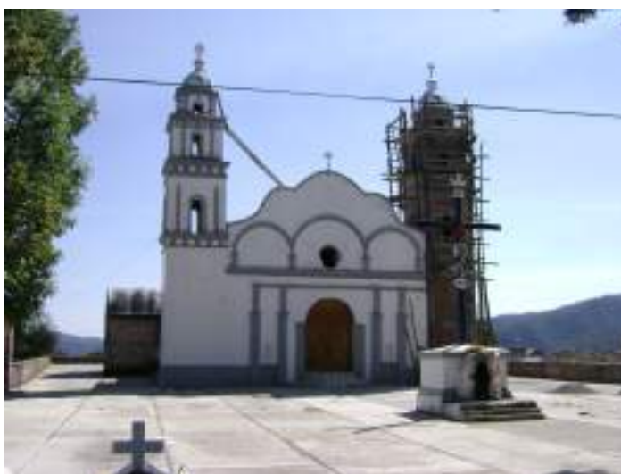
Fotografía No. 11.- Iglesia de Ocoapa, municipio de Copanatoyac
