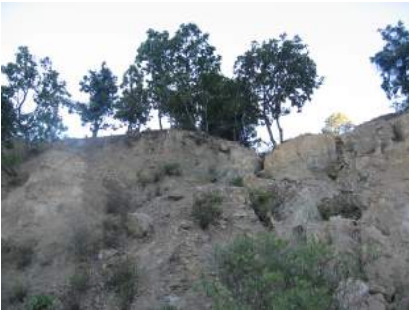
Fotografía No. 6. Formación de cárcavas, carretera Tlapa – Marquelia
