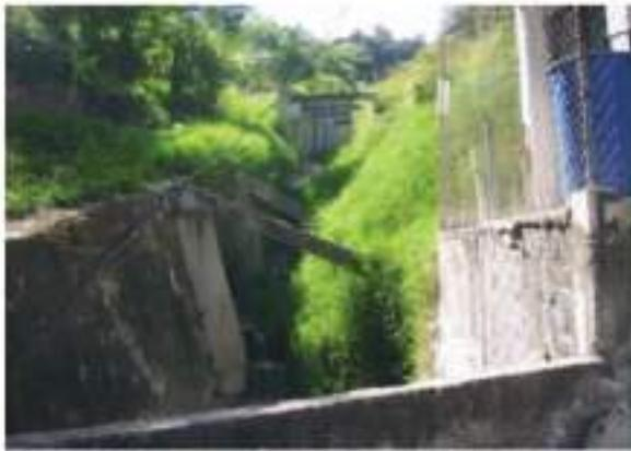
d) Muro de concreto con desplome
