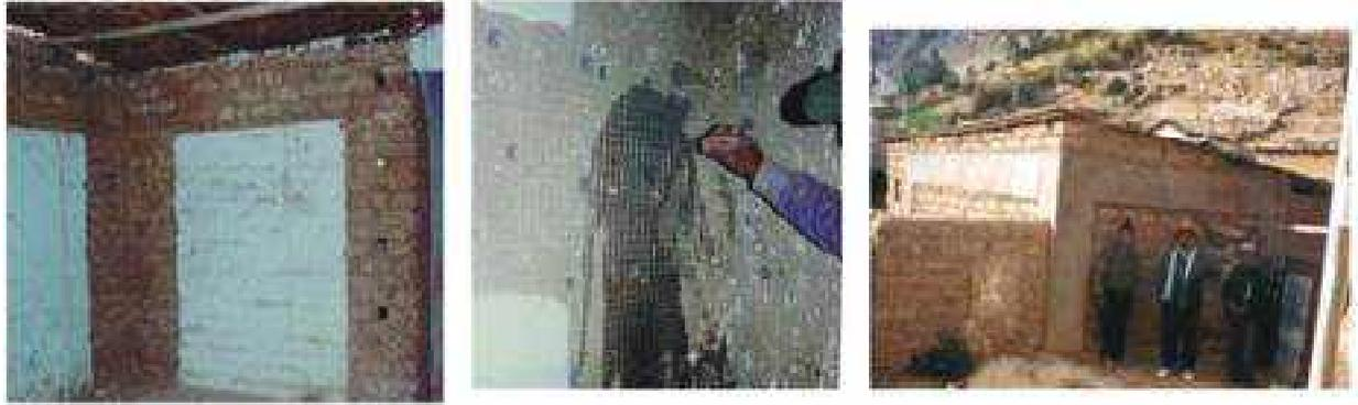
**Fig. 3.6** reforzamiento de la vivienda de adobe con malla y mortero de cemento-arena
