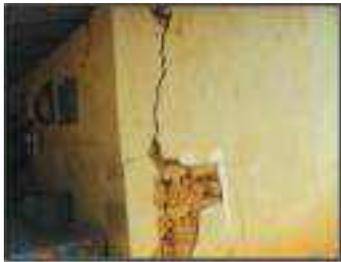
Fig. 4.1 abertura en juntas de muros
