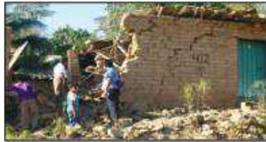
Fig. 4.2 colapso de muros
