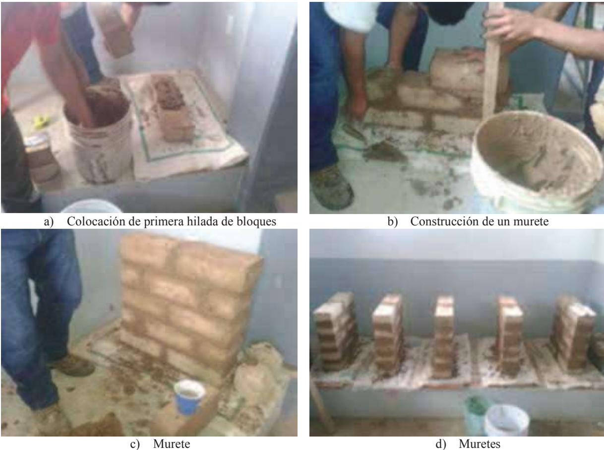
**Figura 12.** Fabricación de muretes.
