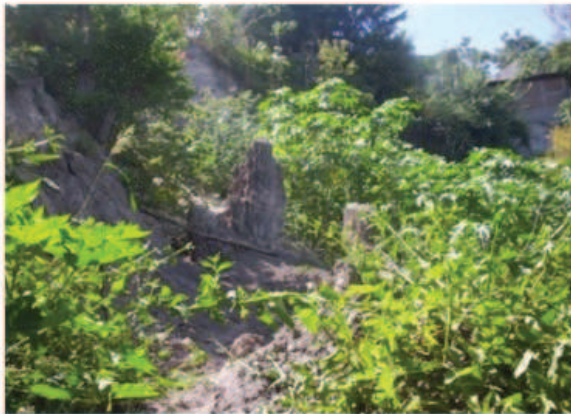
c) Falla de talud
