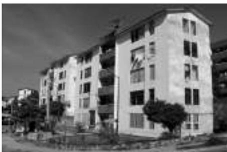
Modelo B: (figura 2, croquis B) posee una cimentación y superestructura de características físicas muy similares a la del modelo A, sólo que en este caso seis muros de mampostería fueron sustituidos por muros de concreto reforzado. El diseño estructural de este tipo de edificios se basó en la norma de 1987. Se dejaron de construir con la entrada en vigor del código de 1989.
