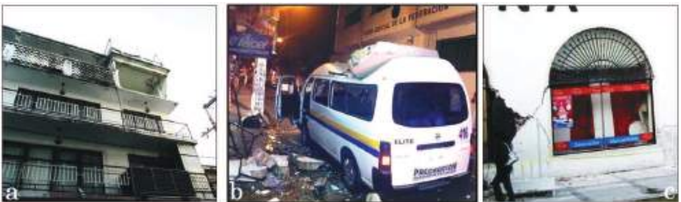
Figura 15. a) y b) Colapso de muro de fachada del cuarto entresijo deficientemente confinado, sobre un vehículo del servicio público. (Fotografías: Wenceslao Hernández, y c) daños en mampostería sin confinar (Fotografía: J. L. Hernández R.)
