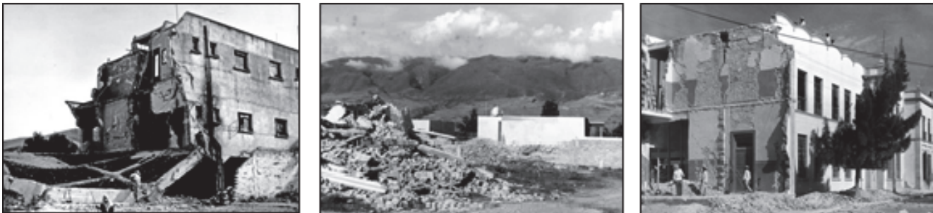
Figura 1. Edificios colapsados en Chilpancingo, Guerrero tras el sismo de 1957. Fuente: Fototeca UAGro, 2011
